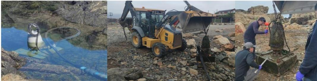
*Figura MA11. Obras de Mantenimiento y reparación Planta Desaladora - bomba de mar*
