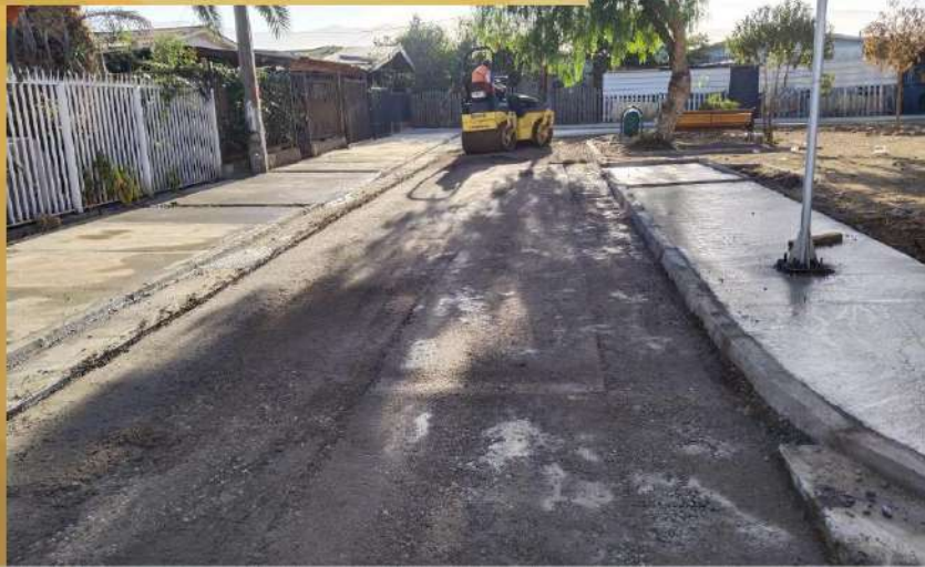
Proyectos de Pavimentación Población Pulmahue
